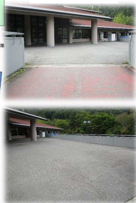
本館入り口（駐車場）
